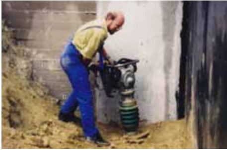
Hans Friedinger rüttelt die Hinterfüllung
