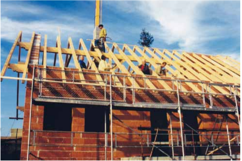
Der Dachstuhl ist fertig
