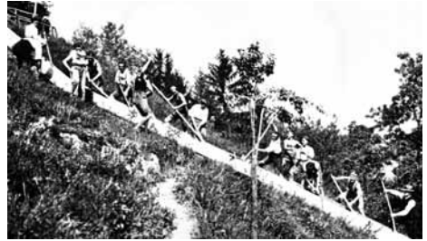
Am 18. Mai 1930 wurde die Wasserpumpleitung über den Hang heraufgelegt.
