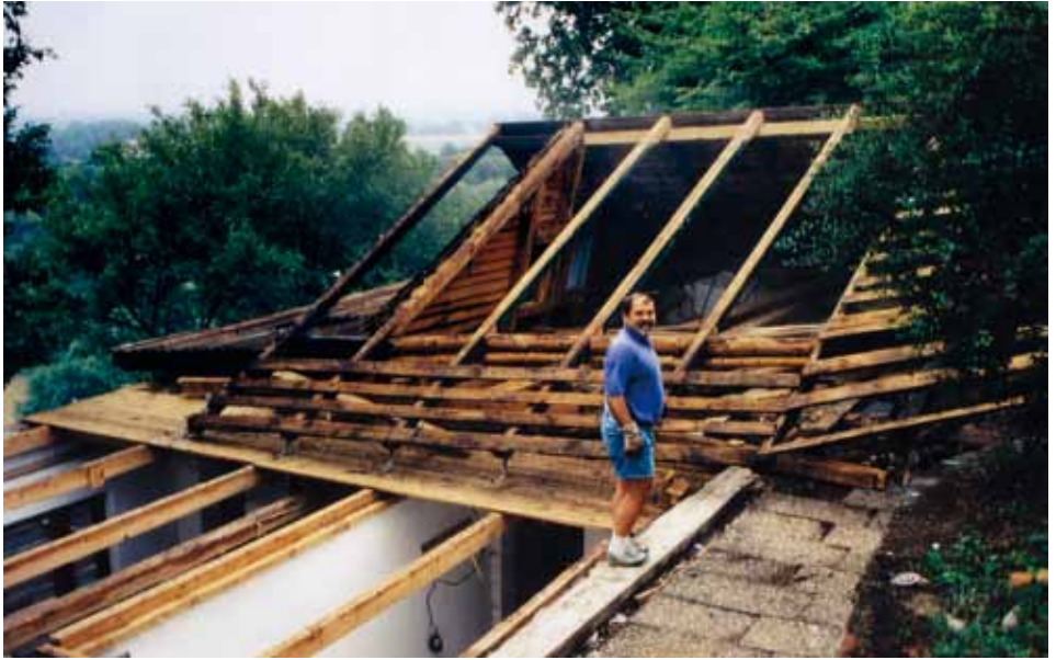
Die Abrißarbeiten sind im vollen Gange
